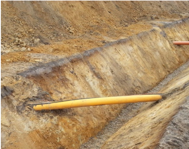
Abb.: Leitungsbau erfolgt in offener Bauweise
